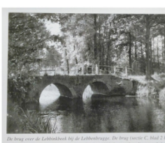
De brug over de Lebbenbeek bij de Lebbenbrugge. De brug heeft 4. maal 2 m
