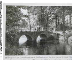
De brug over de Lebbenbrugge bij de Lebbenbrugge. De brug bestaat uit twee steunpieren en is ongeveer 150 m lang. De brug is gebouwd in 1717. Foto uit circa 1900. Naar een tekening van de heer Bannink. De Lebbenbrugge is nu een rijksmonument.
